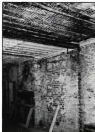
3. Sous le recouvrement de menuiserie à caissons, le curetage a mis à jour l'ancienne finition du plafond: plâtre sur lattes fendues et clouées à la charpente du plancher supérieur. Ces détails ont ainsi permis de dater cette maison vers le milieu du XVIII<sup>e</sup> siècle. Rue Couillard, Québec. (photo: F. Varin)
