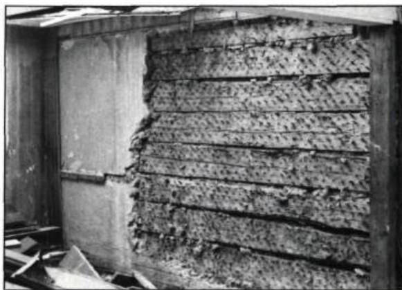
2. Illustration d'une très ancienne technique de recouvrement en plâtre d'un carré en pièces sur pièces. Ce rare vestige, découvert lors de la démolition d'une très vieille maison, montre les chevilles de bois incrustées dans les poutres pour faciliter l'accrochage des couches de plâtre. (photo: R. Bilodeau)
