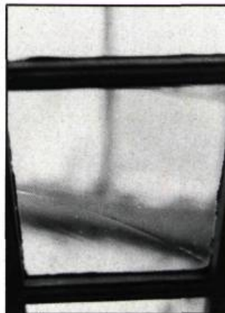
6. Verre en «couronne» où on dénote des bulles ovals recourbées, placées de façon concentrique et des stries ou rayons circulaires, au Séminaire de Québec, Québec. (photo: François Varin)
