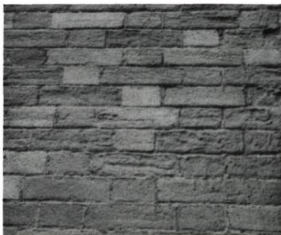
H Maçonnerie de brique nettoyée au jet de sable. Ce procédé a détruit la couche protectrice de la brique et affaibli sa qualité structurale et sa résistance à l'infiltration d'eau, sans compter les piqûres et les balafres qui altèrent l'apparence de la maçonnerie.
