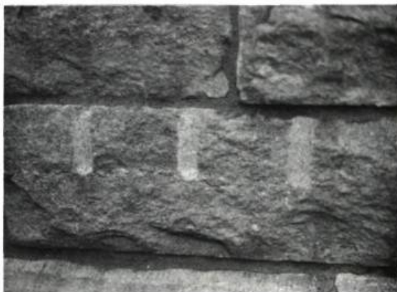
H Maçonnerie de brique nettoyée au jet de sable. Ce procédé a détruit la couche protectrice de la brique et affaibli sa qualité structurale et sa résistance à l'infiltration d'eau, sans compter les piqûres et les balafres qui altèrent l'apparence de la maçonnerie.
