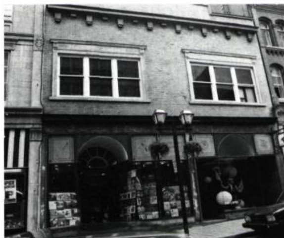
A Deux vues avant et après, d'une maçonnerie nettoyée à l'eau avec l'aide d'un détergent industriel. Ce nettoyage, jumelé à une opération d'ensemble, redonne à l'édifice tout son éclat original et remet en valeur la sobriété de sa conception architecturale.
