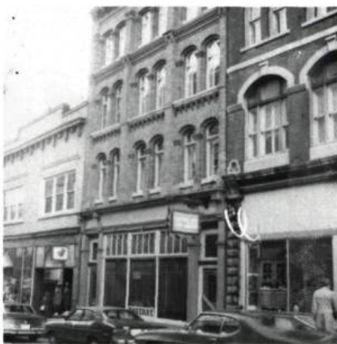
E Nettoyage d'un édifice commercial, rue Saint-Jean à Québec, à l'aide d'une solution chimique. La façade nettoyée gagne en coloris et en luminosité, si on la compare à celle de l'édifice voisin à droite.
