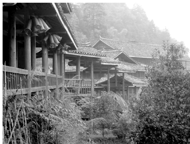
Figure 7 Le centre de ressources écologiques de Dimen
