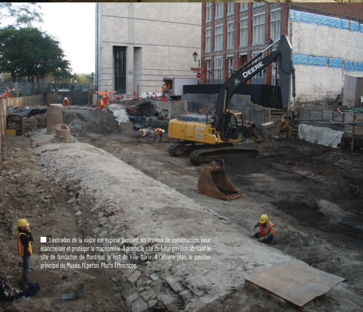
■ La section de l'égout de 1838 mise en valeur à Pointe-à-Callière en 1992. Une partie de la voûte a dû être démontée pour permettre le passage souterrain des visiteurs entre le pavillon de l'Éperon et la crypte sous la place Royale. Photo Jacques Nadeau.
