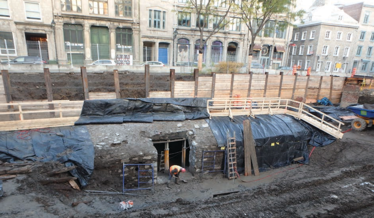
■ L'ouverture au trait de scie dans le piédroit de l'égout pour l'accès souterrain au futur pavillon du Fort de Ville-Marie. Photo Ethnoscop.
