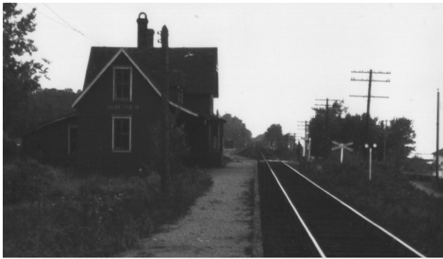
Le 3 février 1946, un coin de la gare de Sacré-Cœur est endommagé par le déraillement d'une douzaine de wagons à l'arrière d'un train de marchandise qui en compte 35. Le bâtiment, près duquel se trouvent une voie principale, une voie d'évitement et une voie de chargement, est vraisemblablement rapidement réparé. L'édifice, qu'on peut voir sur cette photo, est peint en rouge vin à l'extérieur et en beige jaunâtre à l'intérieur. Un jardin, des rosiers sauvages et un petit ruisseau le jouxent. (Coll. Groupe TRAQ).
