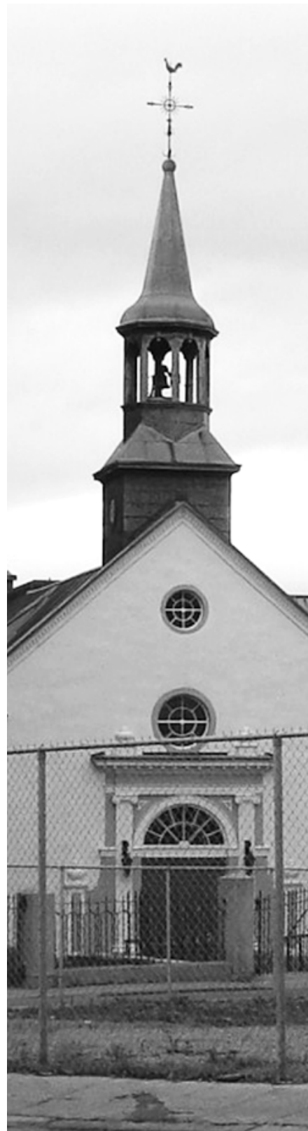
L'église des Augustines-de-l'Hôtel-Dieu-de-Québec, qu'on voyait auparavant seulement en s'aventurant dans la rue Charlevoix est maintenant visible depuis la côte du Palais, une des principales voies d'accès à la haute-ville. (Photo : Antoine Blais-Laroche) (détail).
