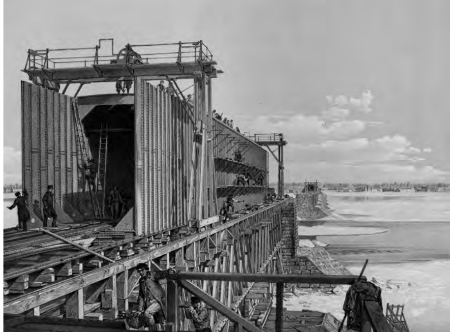
Kell Brothers, d'après S. Russell, d'après William Notman, La construction du tube central du pont Victoria en hiver , Montréal, 1860; lithographie en couleurs, 44 x 59,8 cm (papier); 21,7 x 28,8 cm (image). Don de Michel Morisset, 2012.425. (Photo MNBAQ, Denis Legendre).
