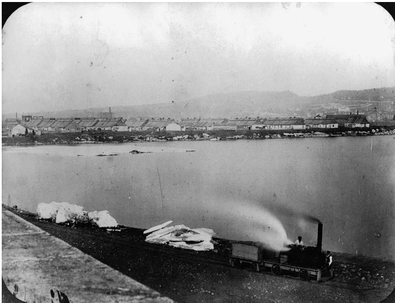
Sheds de Pointe-Saint-Charles depuis le haut du pont Victoria, Montréal, Qc, 1858-1859. Photographie de William Notman. (Musée McCord).
