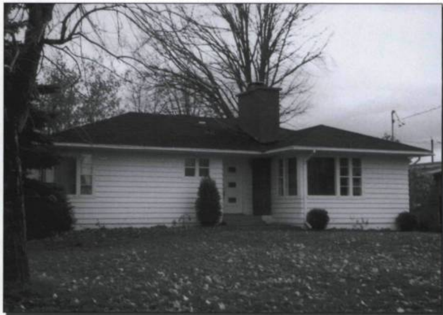
430 M.Vict., 1954. Bungalow construit en 1954 à Verchères sur des plans acquis par le biais d'un magazine étasunien. Elmer Gylleck (1898-1989), architecte. (Collection de l'auteur).
