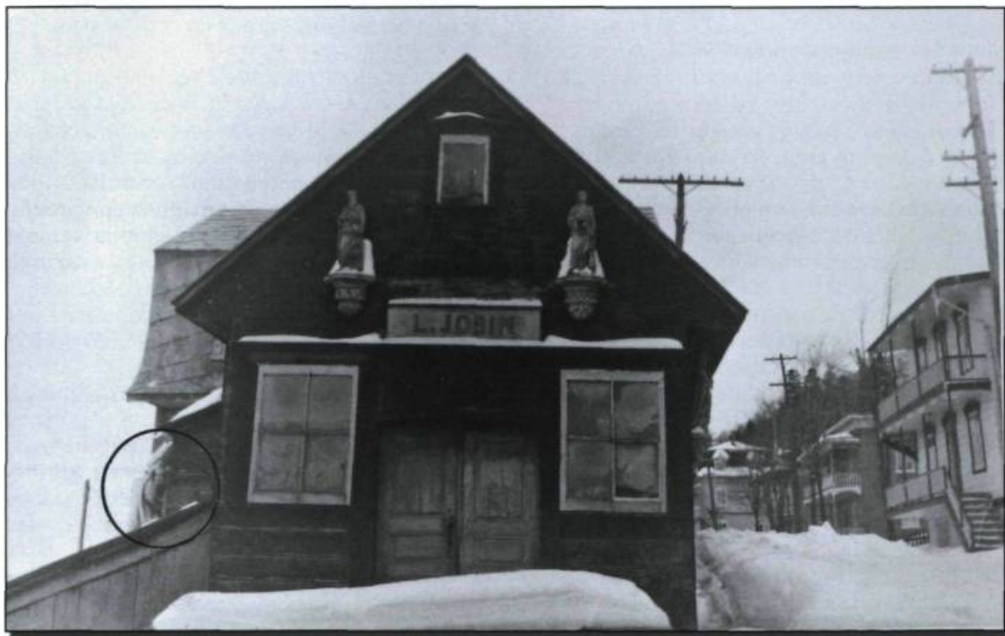
Vue du premier atelier de Louis Jobin à Sainte-Anne-de-Beaupré, prise en hiver vers 1915 et montrant le Napoléon à gauche, sur le mur du côté sud donnant sur le fleuve. Photo anonyme. (Archives de la basilique de Sainte-Anne-de-Beaupré).
