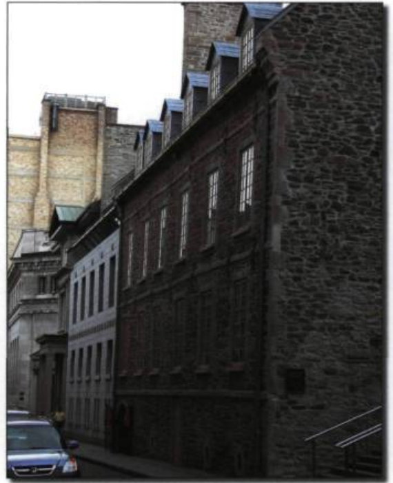
Maison Estèbe, 1750, rue Saint-Pierre, Québec. La position des lucarnes à la base du toit et le bandeau au-dessus des dernières fenêtres indiquent la présence d'une charpente à surcroît. Photo : Marc Grignon, 2003.
