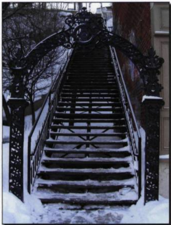
Escalier Lépine, Charles Baillairgé, 1882. Construit dans un style néoclassique, l'escalier de fer possède toujours l'arche originale à son pied. Photo : Josée Alain, 2004.
