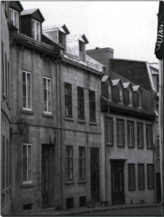
La rue Couillard aujourd'hui. La position des lucarnes et des fenêtres supérieures dans ces maisons découle de l'existence d'un surcroît, une caractéristique remontant au XVII e siècle. Photo : Marc Grignon, 2003.
