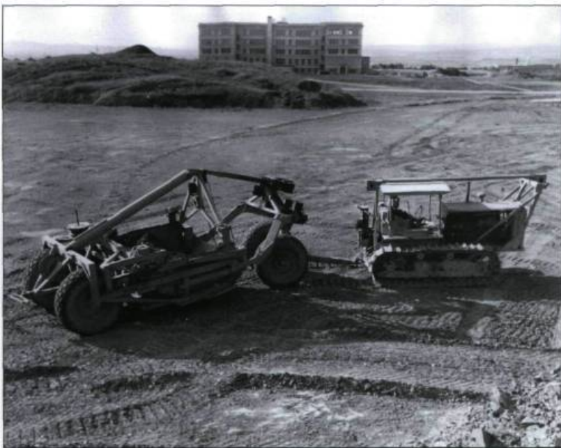
Travaux d'aménagement du nouveau campus près du pavillon érigé en 1946 pour loger la Faculté d'arpentage et de génie forestier. Photographie de E. Nesbitt, vers 1950. (Archives de l'Université Laval).
