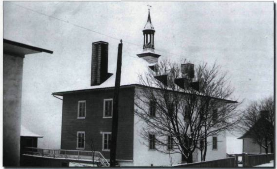
Le deuxième couvent de Château-Richer, construit en 1830. (Archives des sœurs du Bon-Pasteur de Québec).
