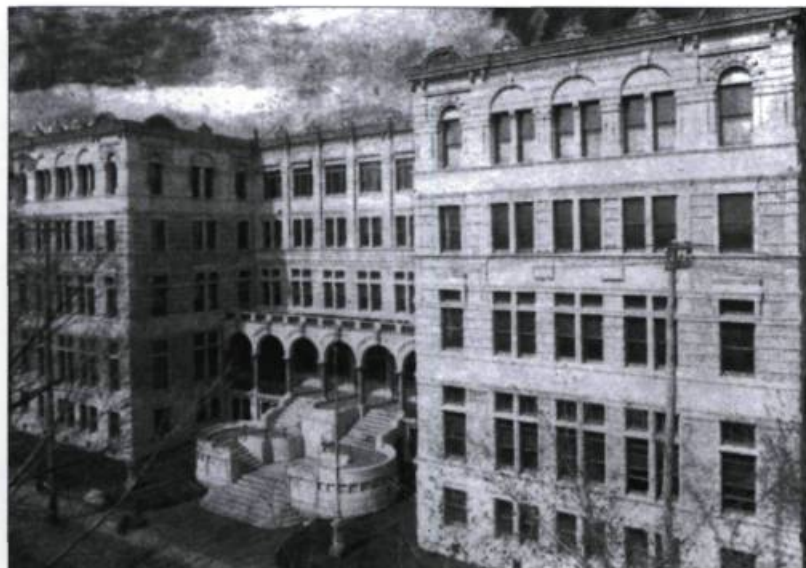
En 1876, M gr Ignace Bourget accepte le projet de Rome d'établir à Montréal une succursale de l'Université Laval de Québec. Ce n'est qu'en 1919 que cette entité obtient son autonomie complète et devient l'Université de Montréal. Ici, l'édifice érigé entre 1893 et 1895, d'après les plans de Joseph Venne, pour abriter la succursale montréalaise de l'Université Laval. (Collection privée).
