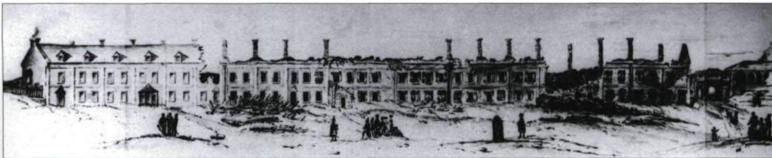
Dégâts causés aux Nouvelles Casernes par l'incendie de 1851. G. Ranken, 1852. (Public Record Office, Londres).
