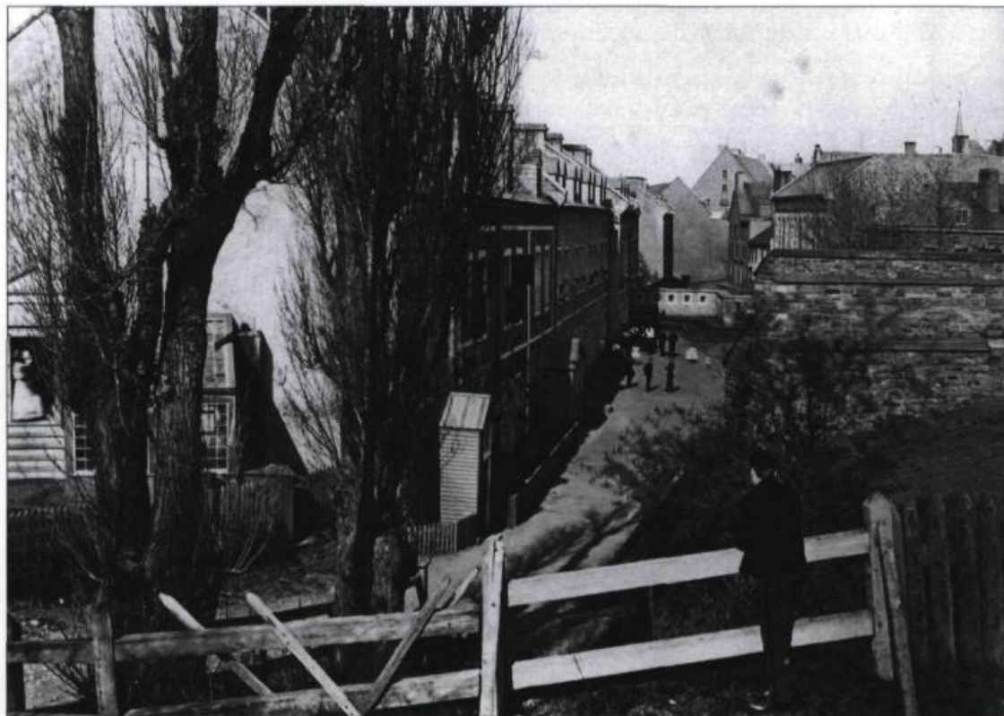
Les Nouvelles Casernes vues du demi-bastion du coteau de la Potasse. L'extrémité ouest de l'édifice, épargnée par l'incendie de 1851, présente toujours certaines caractéristiques du classicisme français qui soulignent en façade les divisions intérieures de l'édifice. La photographie, prise à la veille du départ de la garnison britannique, en 1871, illustre aussi la section non reconstruite de l'édifice, en 1852. Photographie de Livernois et Bienvvenu. (Archives nationales du Québec, à Québec).
