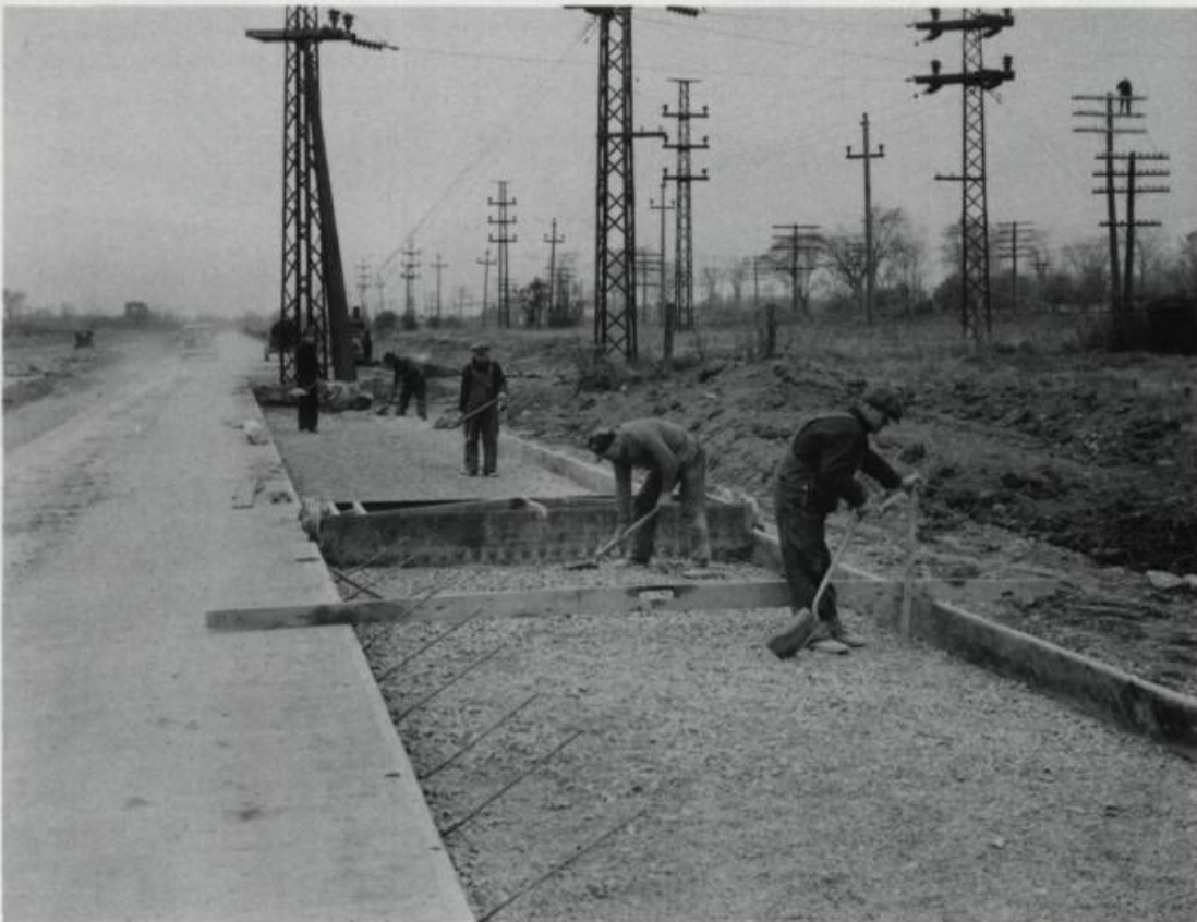
Construction d'une route vers 1945. Photo Associated Screen News Ltd.
