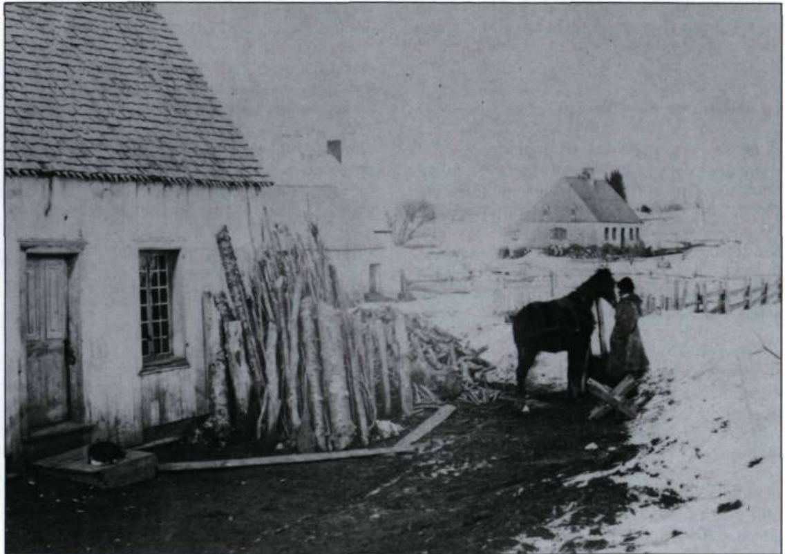
Une maison de l'île d'Orléans en 1858. Encore proche du modèle des origines, celle-ci est couverte de planches verticales et son toit est de bardeau. Le bois de chauffage se trouve à portée de la main. La maison au second plan est déjà plus spacieuse avec sa cheminée centrale. «Habitant Cottage Lower Canada». Photographie de Samuel McLaughlin, 1858. (Collection de l'auteur).
