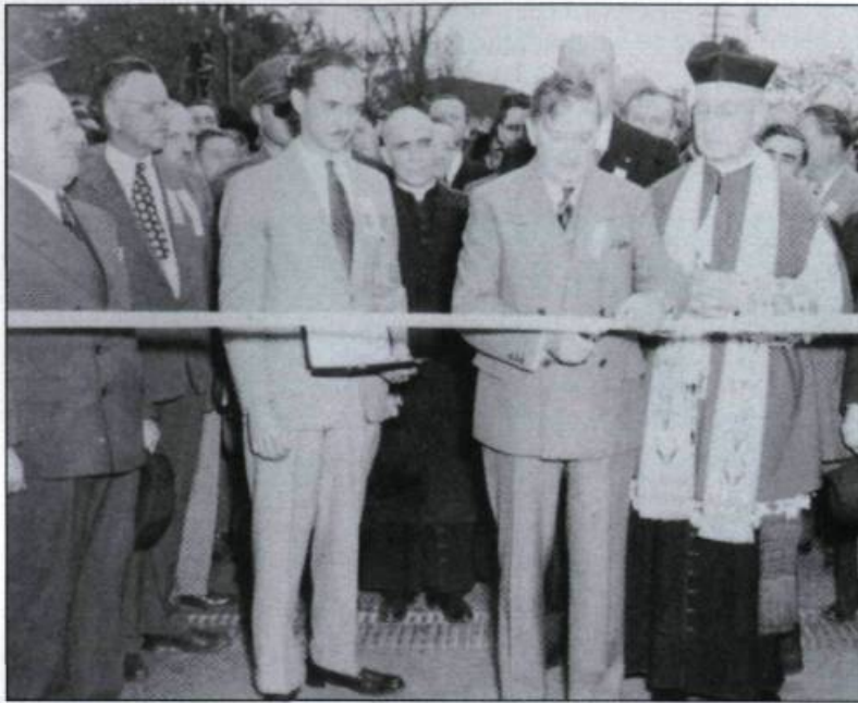
Le 6 juin 1948, Maurice Duplessis inaugure le nouveau pont de Trois-Rivières. Le premier ministre déclare alors que cette structure est aussi solide que l'Union nationale. Le pont s'écroule deux ans plus tard. (Archives nationales du Canada).
