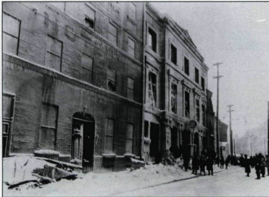
Érigé en 1851-1852, selon les plans de l'architecte Charles Baillairgé, l'édifice du Music Hall s'inspire du style Greek Revival caractérisé par la présence de colonnes doriques, rosettes et têtes de lion. (Archives nationales du Québec, Collection initiale).
