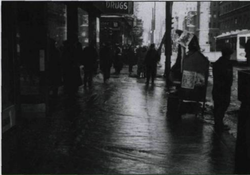
Bris d'aqueduc, rue Sainte-Catherine, Montréal, juin 1937 par Conrad Poirier. (Archives nationales du Québec à Montréal).
